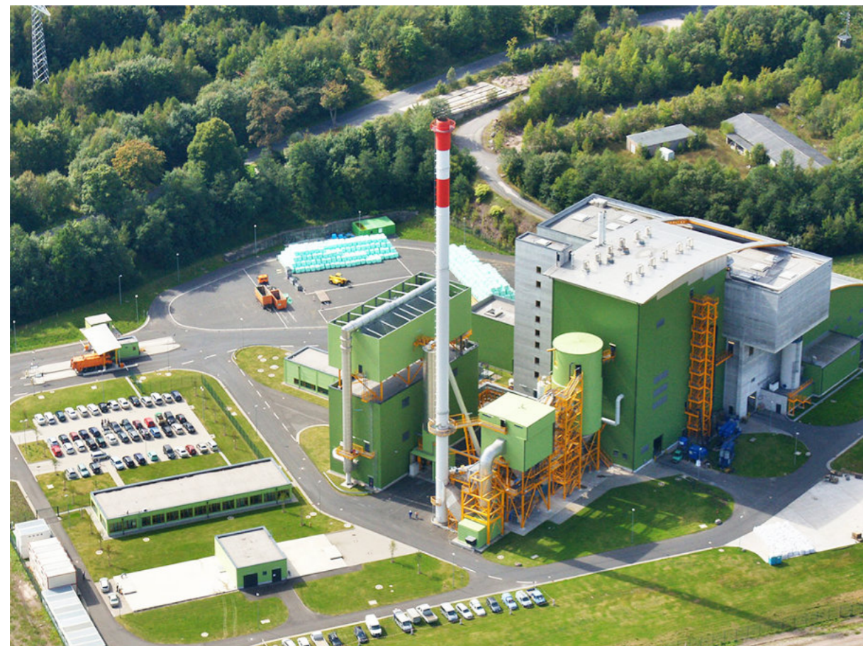
Abb. 5.96 | Restabfallbehandlungsanlage (RABA) Südwestthüringen
