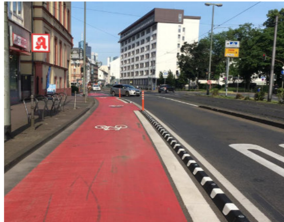
Abb. 5.61 | Beispiel: Umnutzung einer Spur als Radfahrstreifen
