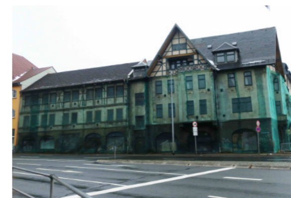
Abb. 5.66 | Leerstand mit Sanierungsbedarf Bahnhofstraße/Dr.-Theodor-Neubauer-Straße
