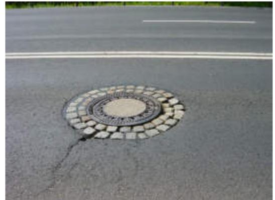
Fahrbahnschäden und mangelhafte Kanaldeckel-Einpflasterungen im Bereich unterhalb Hohe Loh bis Einmündung Künigunde – Anlieger klagen deshalb über starke Lärmbelastung besonders durch Lkw (alle Gefahrgut-Transporte von der Autobahn).
